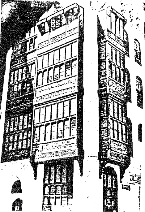
صورة (٦-٢) صورة لمبنى تقليدي ذي رواشين جميلة بمكة المكرمة وقد نال حظاً من الصيانة والمحافظة
